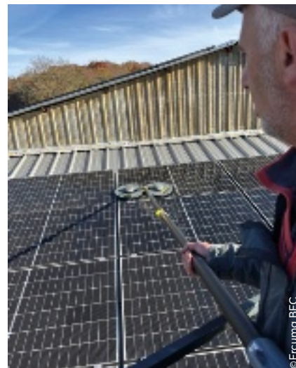
Entre contraintes techniques et coût, la démonstration de nettoyage n'a pas convaincu...
