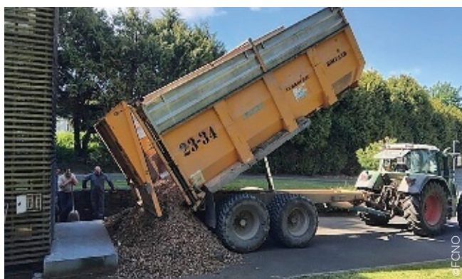
Le 16 mai, la chaufferie de l'Ehpad réceptionnait une première livraison de plaquettes bocagères en provenance de la plateforme de stockage située à 3 km.
