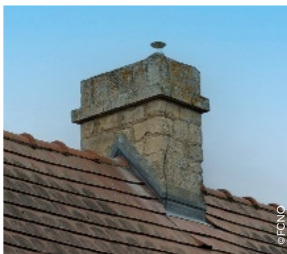
Sur son site de Maltot, la fédération des cuma a récemment installé une antenne Centipède RTK.
