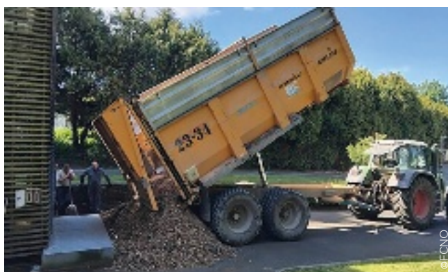
Le 16 mai, la chaufferie de l'Ehpad réceptionnait une première livraison de plaquettes bocagères en provenance de la plateforme de stockage située à 3 km.
