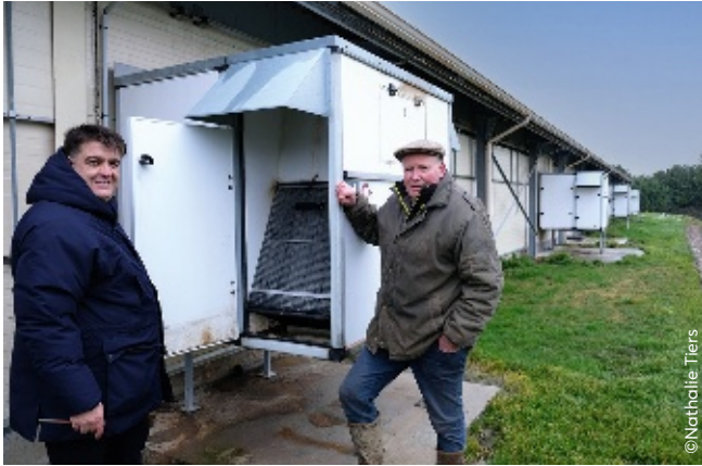
En Ille-et-Vilaine, l'éleveur de canards Bernard de la Morinière (à droite) a divisé par trois sa consommation de gaz. Une ventilation avec échangeur à plaques récupère les calories de l'air sortant.
