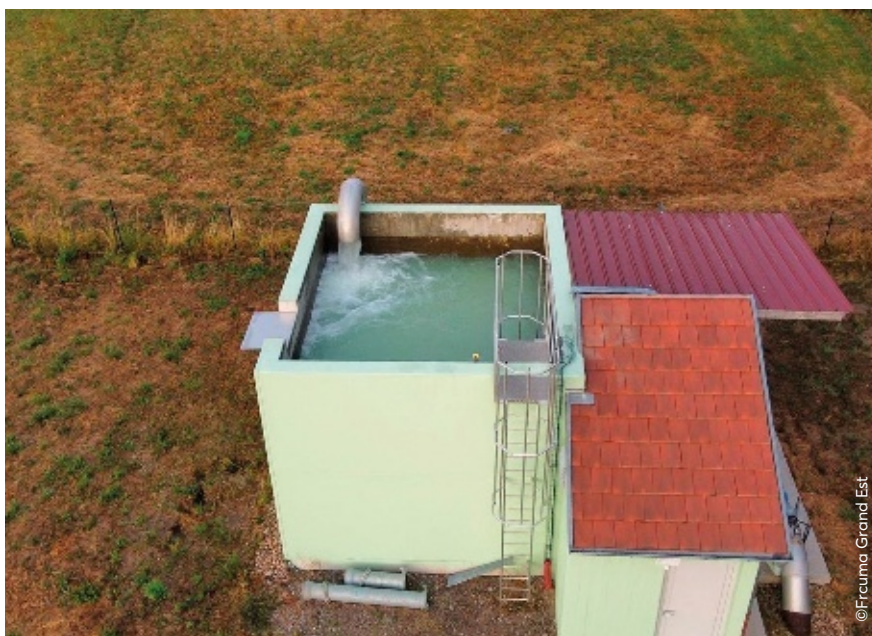
Cette deuxième station de pompage a une petite réserve et comporte quatre pompes qui mettent l'eau sous pression et qui peuvent monter jusqu'à 500m 3 /h de débit avec 14 bars de pression à la sortie.
