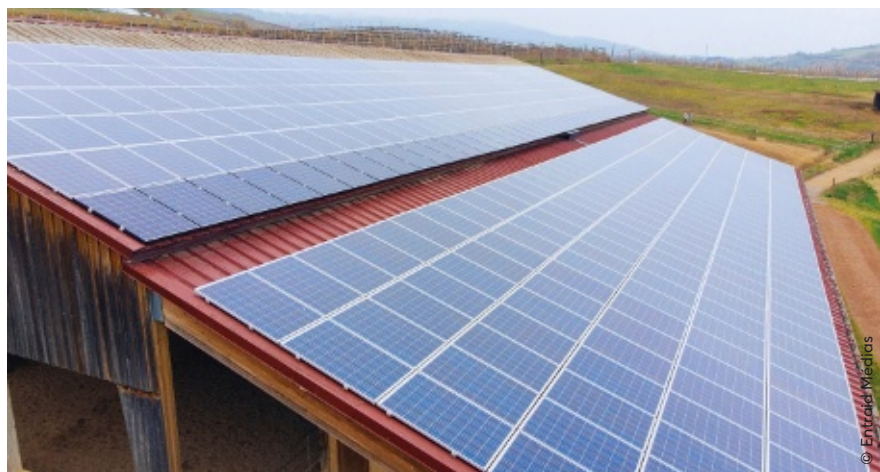
Le photovoltaïque financera le futur bâtiment de la cuma.
