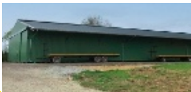
La cuma d'Orgères finance une partie de la construction de son hangar grâce à l'activité photovoltaïque.
