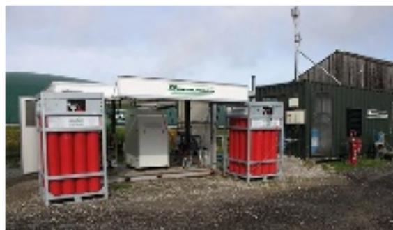
Récompensé au SIMA 2022, le système Bennamann capte le méthane émis par les fosses à lisier et le valorise en carburant.
