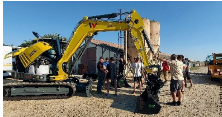
Mise en route de la minipelle Wacker Neuson de 8 tonnes de la cuma de Bouzy sur le secteur de Château-Renard.
