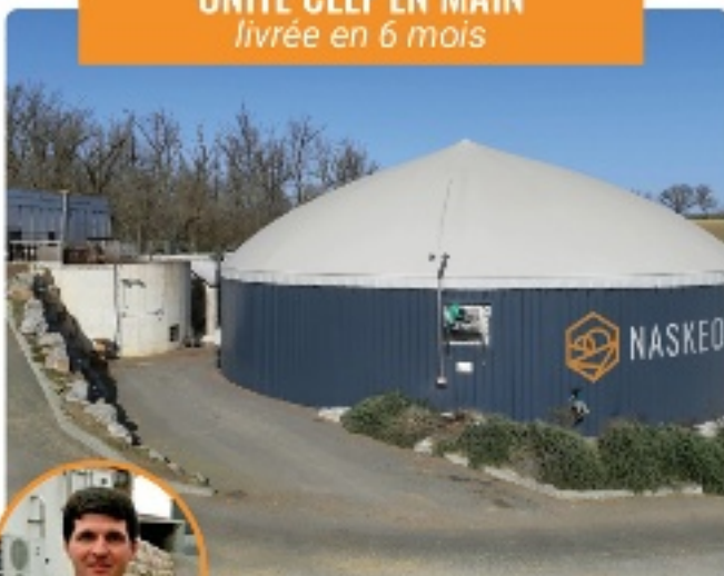
Matthieu Larroque a fait confiance à NASKEO pour construire son unité MONO-MÉTHA® à Lagny-sur-Marne qui traite 9 000 tonnes de déchets organiques par an (fumiers, cves, cannes de maïs)
